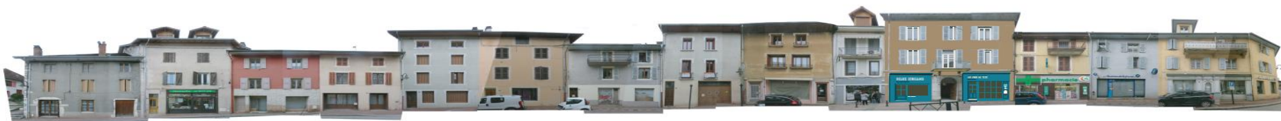
Essai 01 - traitement façade lot 08 - Rue Jean Jacques Rousseau
