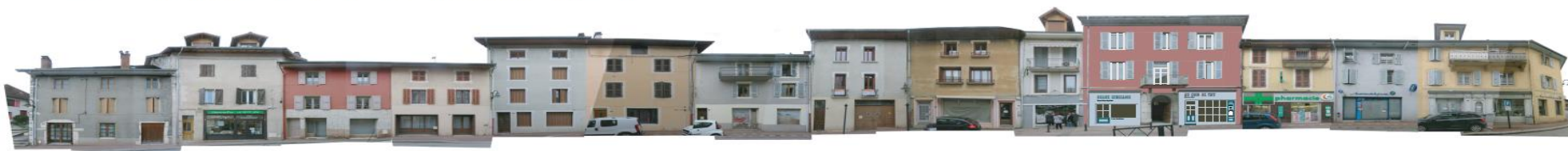
Essai 02 - traitement façade lot 08 - Rue Jean Jacques Rousseau
